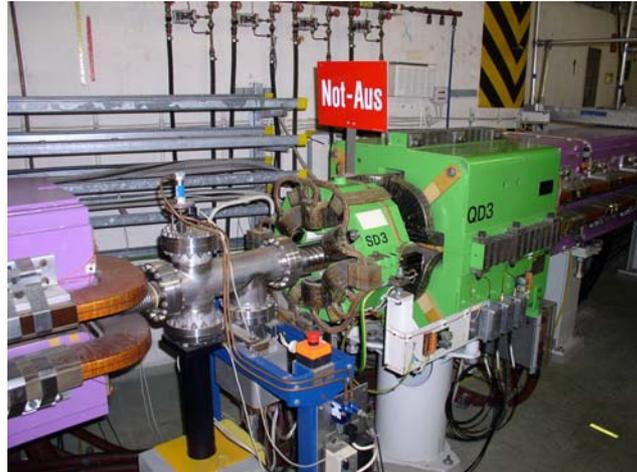
Abbildung: Notausschalter in DESY2/DESY3 befinden sich zum Schutz in regelmäßigen Abständen von etwa 10 m ( teils ringinnen, teils ringaussen ).
