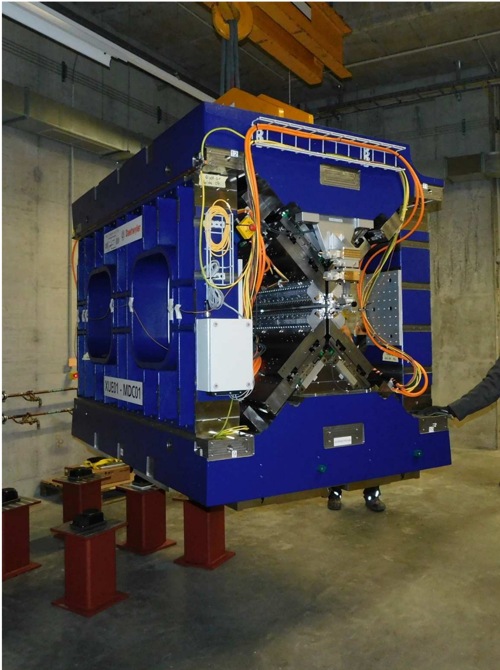
Erster Afterburner-Undulator beim Einbringen in den Tunnel.
