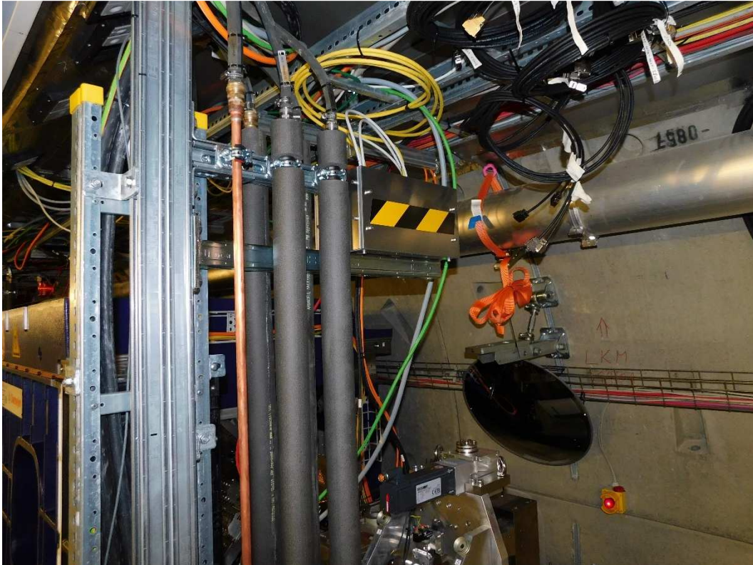
Abschirmbox für vier Dosiboxen (bei 2948m) der Afterburner-Undulatoren.
